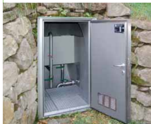
Porta d'entrata di una cisterna per l'acqua potabile
